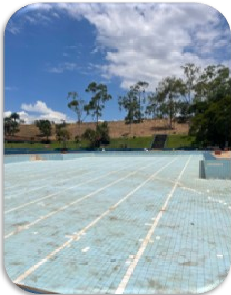
Reforma das piscinas
